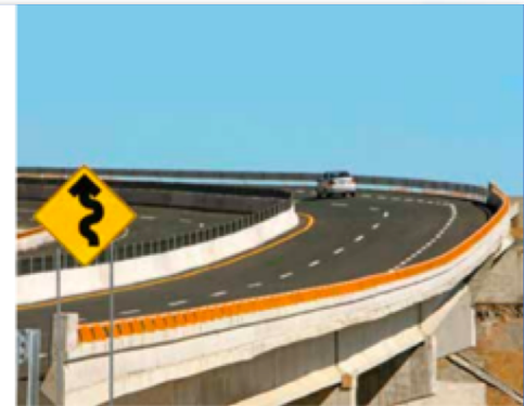
Autopista Amecameca-Cuautla. Fuente: Presidencia de la República, 2014
